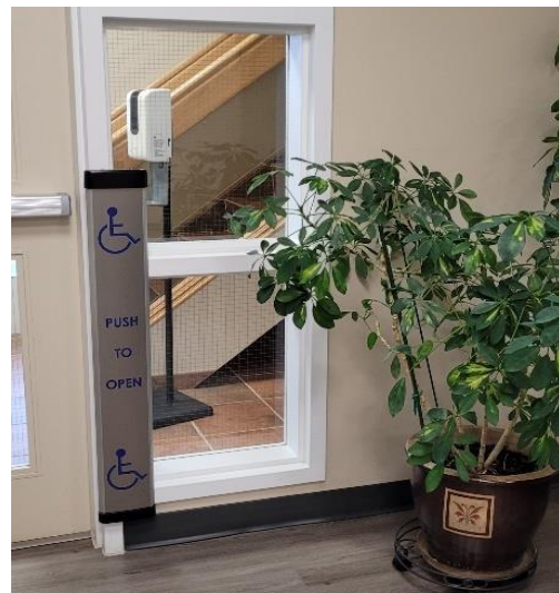
Image : Ouvre-porte automatique installé au bureau municipal.
